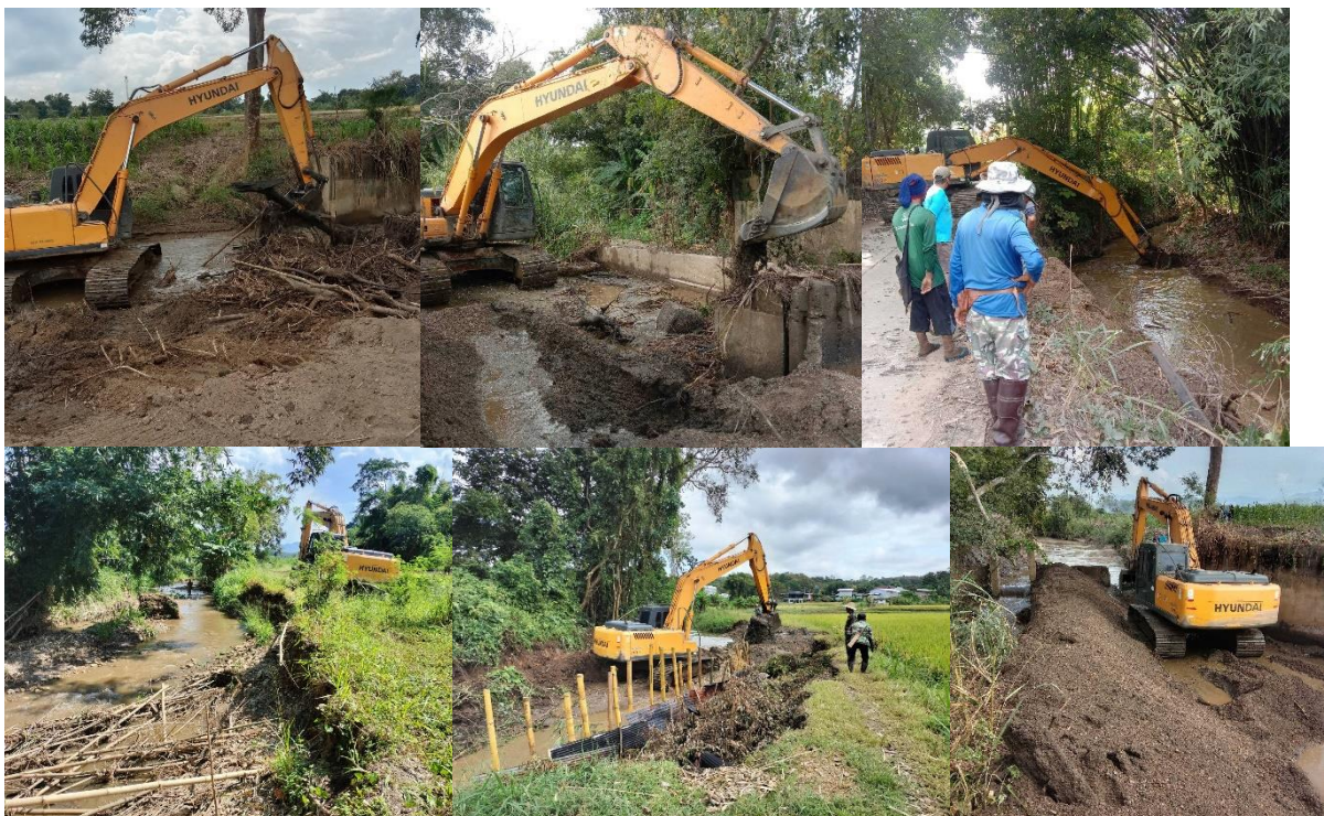
๔. ขุดและวางท่อระบายน้ำหมู่ต่าง ๆ
