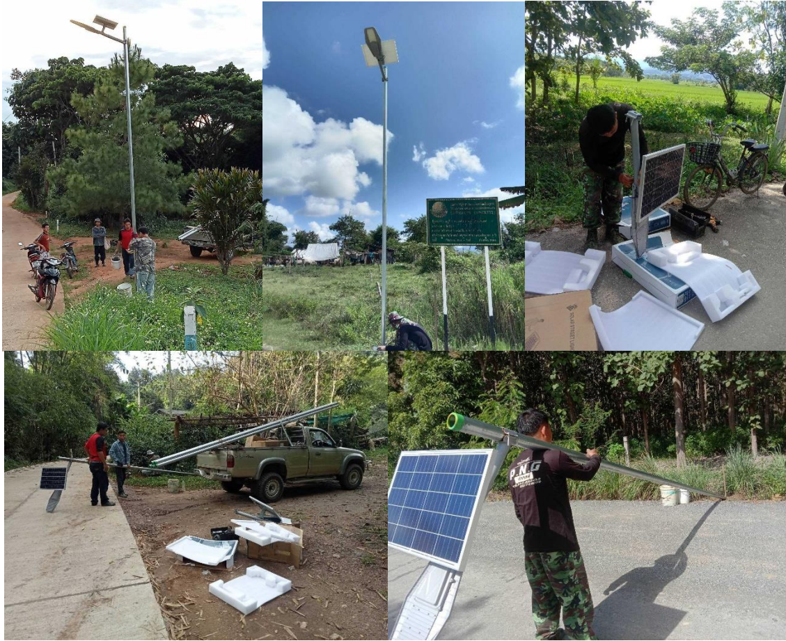
๓. การติดตั้งไฟฟ้าส่องสว่าง โครงการติดตั้งไฟกิ่งสาธารณะแบบโซล่าเซลล์ ๖๕ จุด
