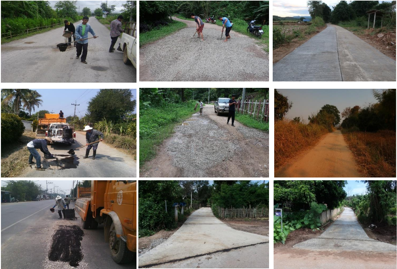
๑. โครงการก่อสร้างถนน คสล. และการซ่อมแซมบำรุงรักษาถนน
